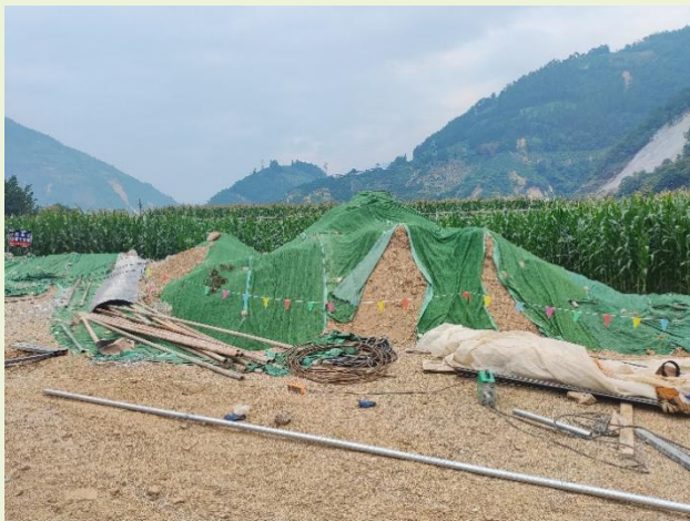
图 2.1-3 场地内临时堆放表土
