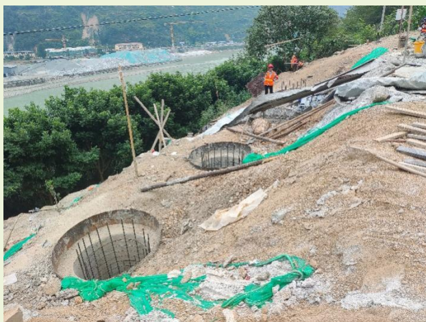
图 2.1-2 农事瞭望塔建设现状
