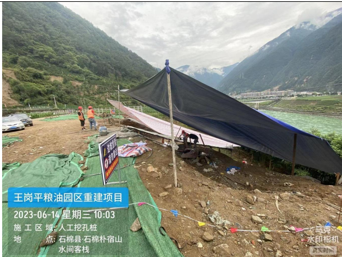
图 5 施工期临时遮盖
