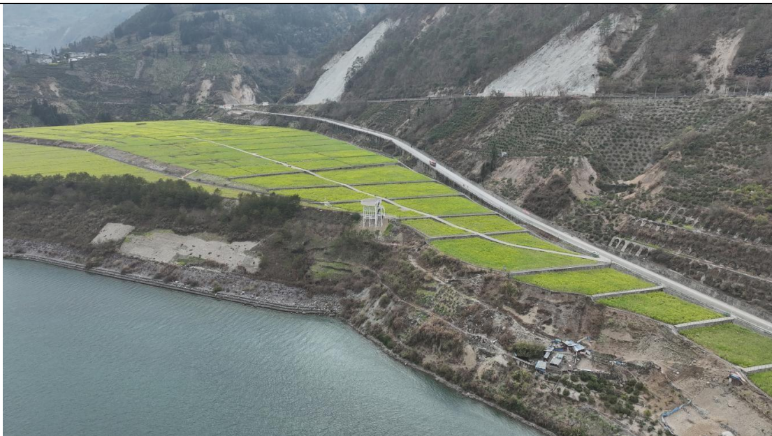
图 3 农机化生产道路恢复现状
