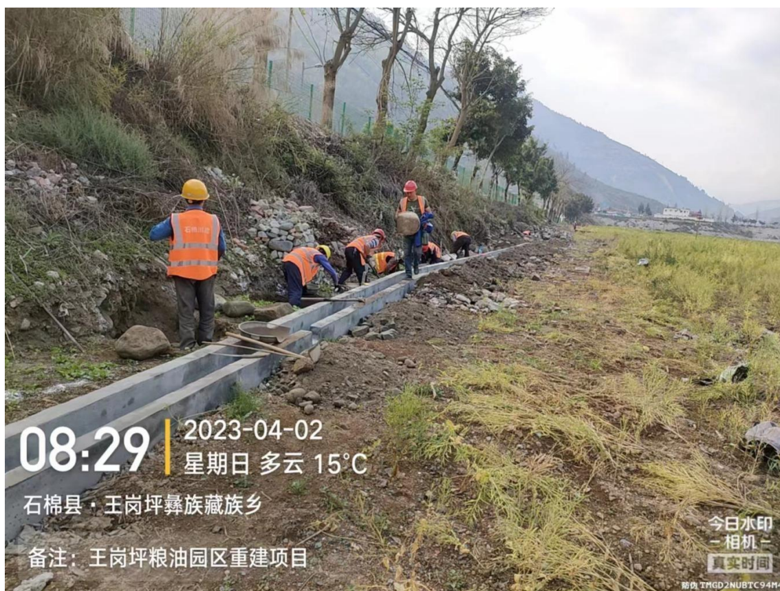
图 7 施工期修建排水沟
